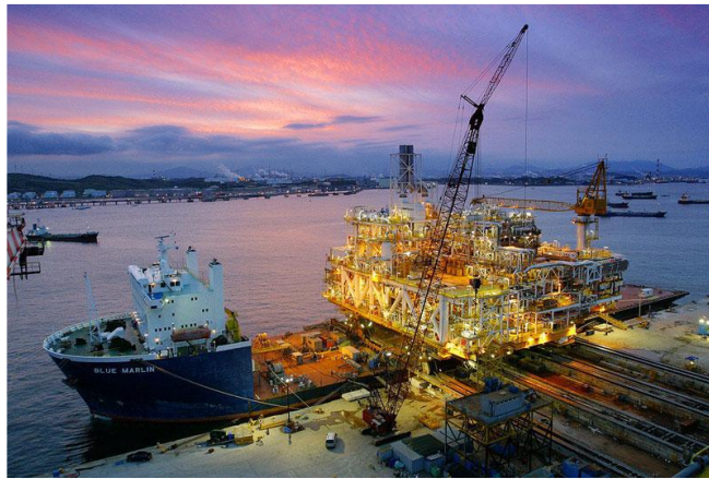
Рис. 1. Вивантаження надважкого вантажу по рейках на берег
